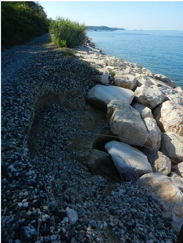
Figura 5 Punto di erosione localizzato AREA DI INTERVENTO 2
