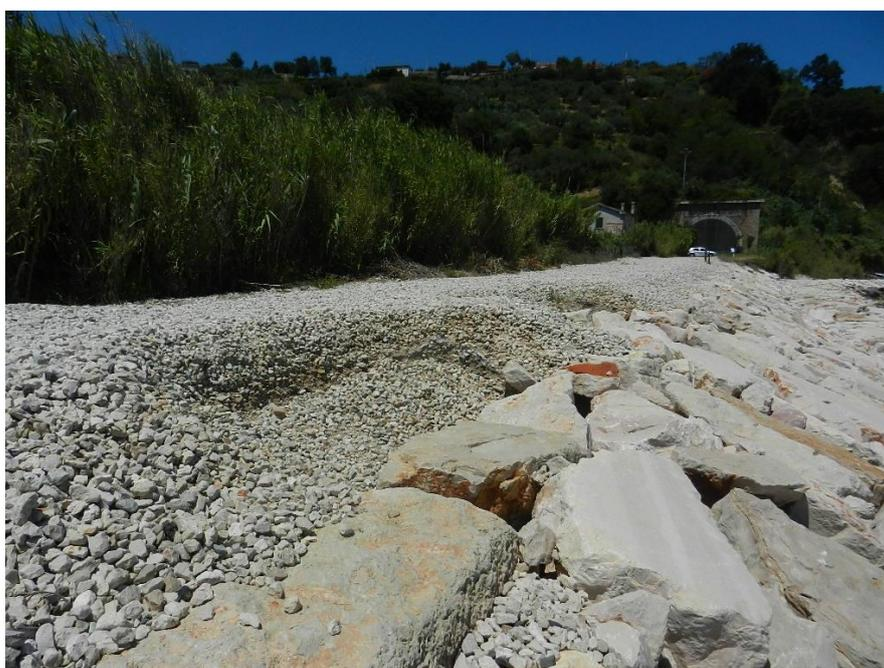
**Figura 2 Punti di erosione localizzata AREA DI INTERVENTO 1**
